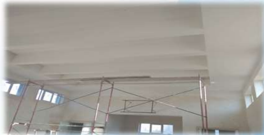
капітальний ремонт спортивного залу та допоміжних приміщень Свалявської ЗОШ І–ІІІ ступенів № 1 Свалявської районної ради
