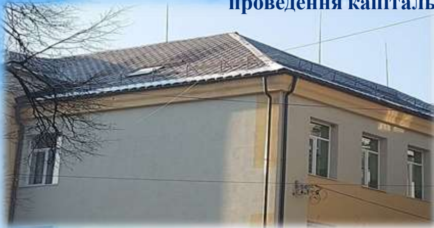
капітальний ремонт даху корпусу Міжгірської ЗОШ І–ІІІ ступенів №1 Міжгірської районної ради 1 304,1 тис. грн
